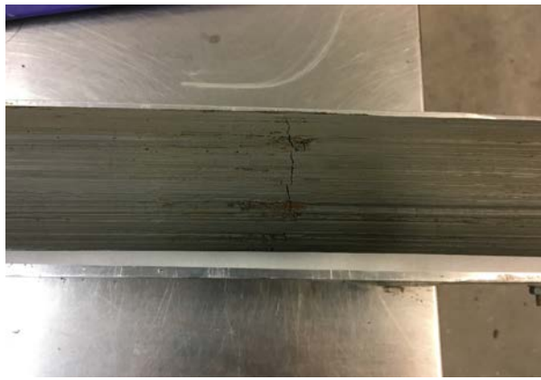
Photographie n° 2 : Présence d'une fissure (0,26 - 0,36 m*) Échantillon # 246 930 / TF-21-05 SH-21
