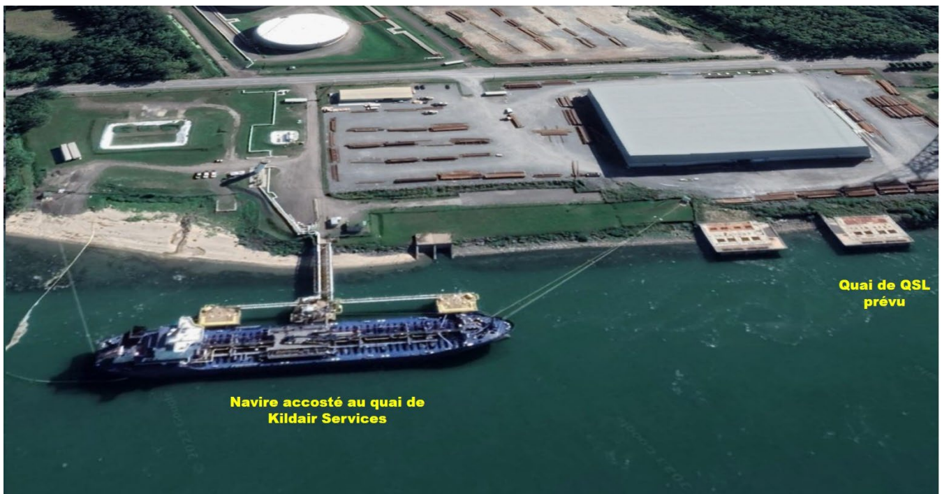
Situation présente, avant la construction du quai de QSL
