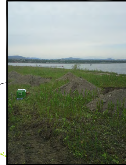
Photo 4 - Réalisation des tranchées exploratoires de la cellule T2-15
