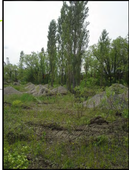
Photo 3 - Réalisation des tranchées exploratoires de la cellule T2-12
