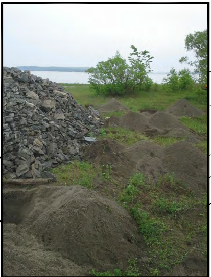
Photo 1 - Réalisation des tranchées exploratoires de la cellule T2-03
