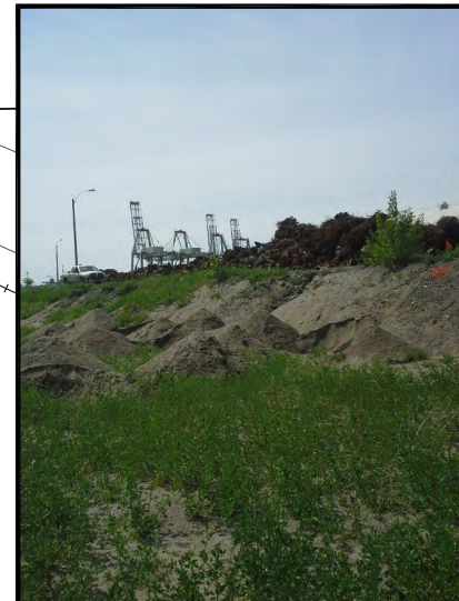
Photo 2 - Réalisation des tranchées exploratoires de la cellule T2-06
