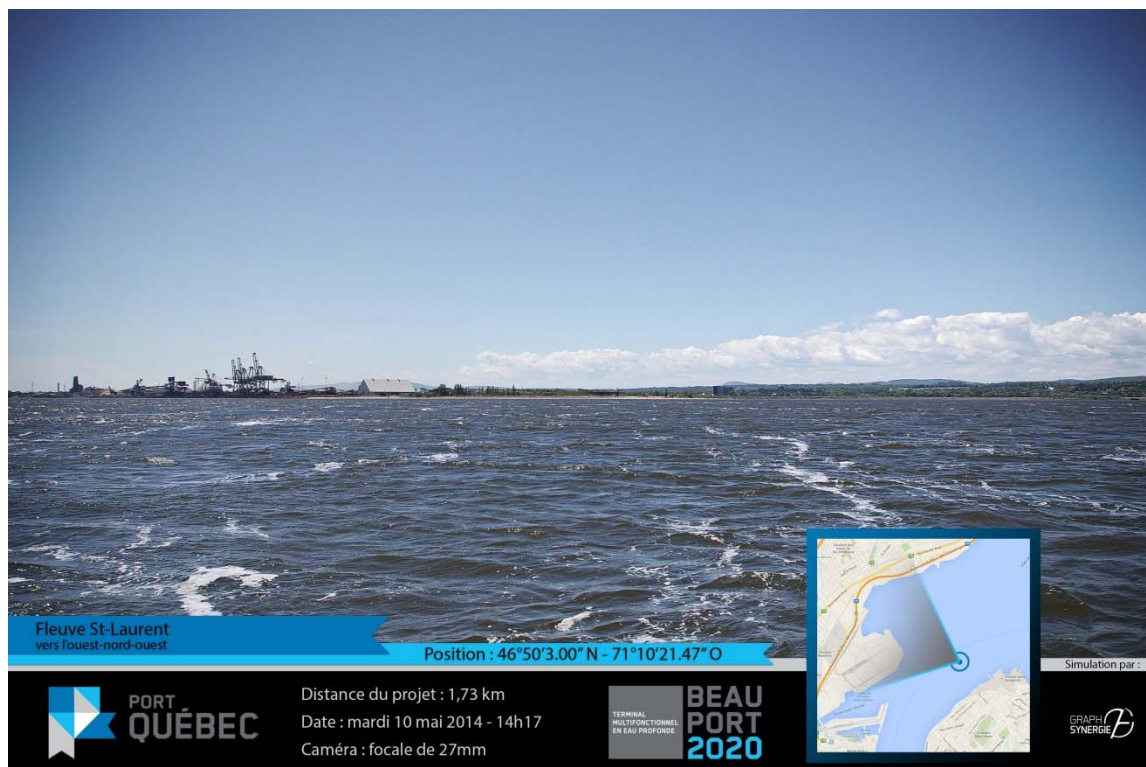
Figure 10.47 Fleuve Saint-Laurent (voie maritime) – Hauteur de Chantier Davie Canada inc. (état de référence)
