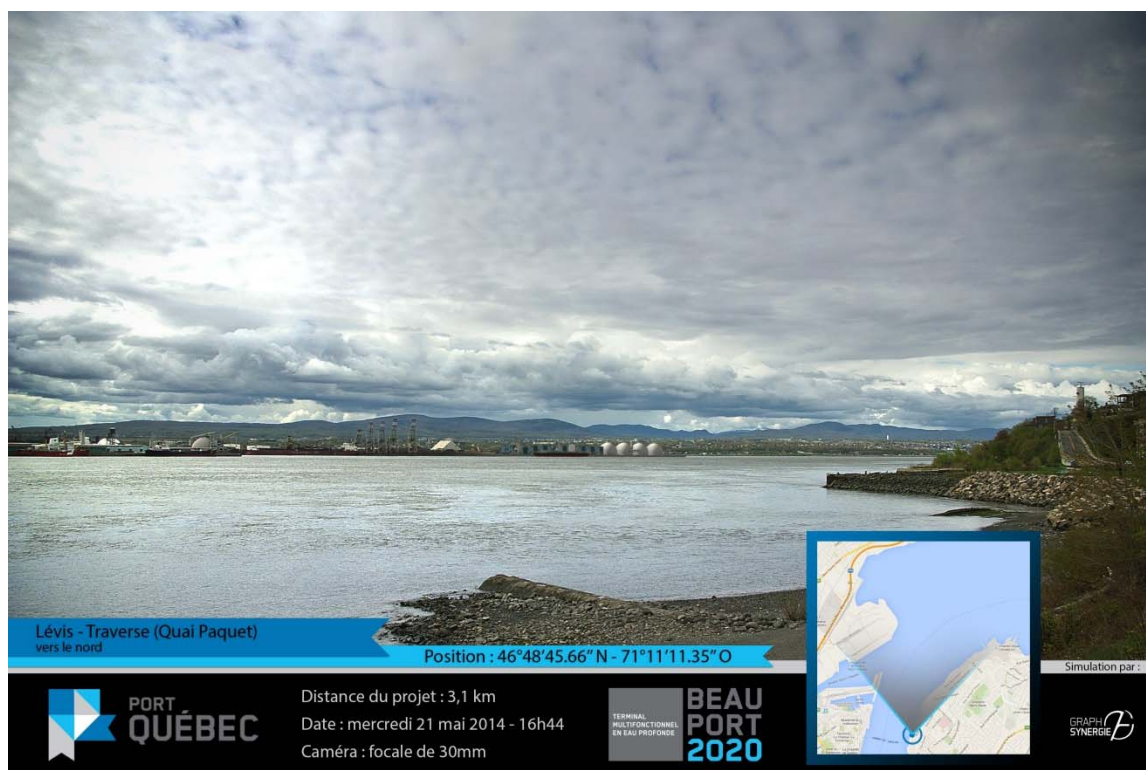
Figure 10.44 Lévis – Quai Paquet (phase d'exploitation)
